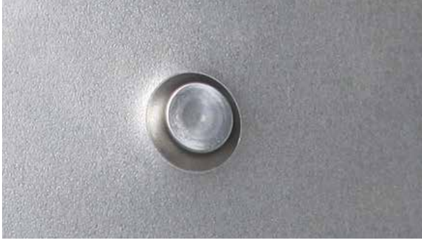
RESULTADO AL PONER UN REMACHE AUTOPERFORANTE
